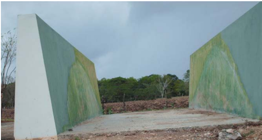
Silo horizontal en casa de Alto, San Francisco Macorís, República Dominicana
