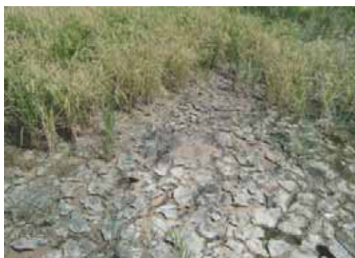
Foto 98. Daños de caracoles (acumulados)
