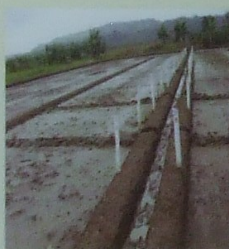
Preparación de muros
