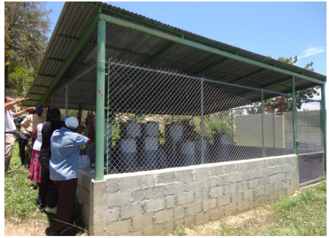
Edificación ubicada en la parte posterior del Centro propuesta para establecimiento de sala de extracción de miel comunitaria.
